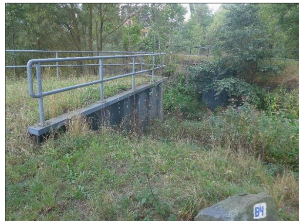
Abb. 20: Östlich der B 253 befindet sich ein Drosselbauwerk für den Durchfluss der Perf
