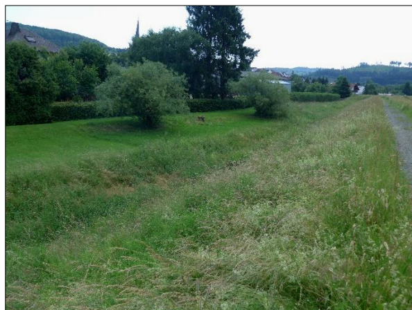
Abb. 12: Blick auf die Flutmulde von Westen
